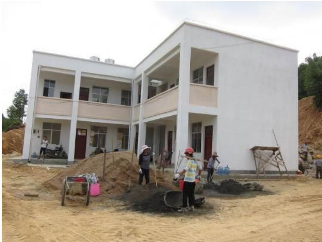
(1) 教学楼正面及右侧 (工人正在进行护坡施工(非苗圃协议内容))
