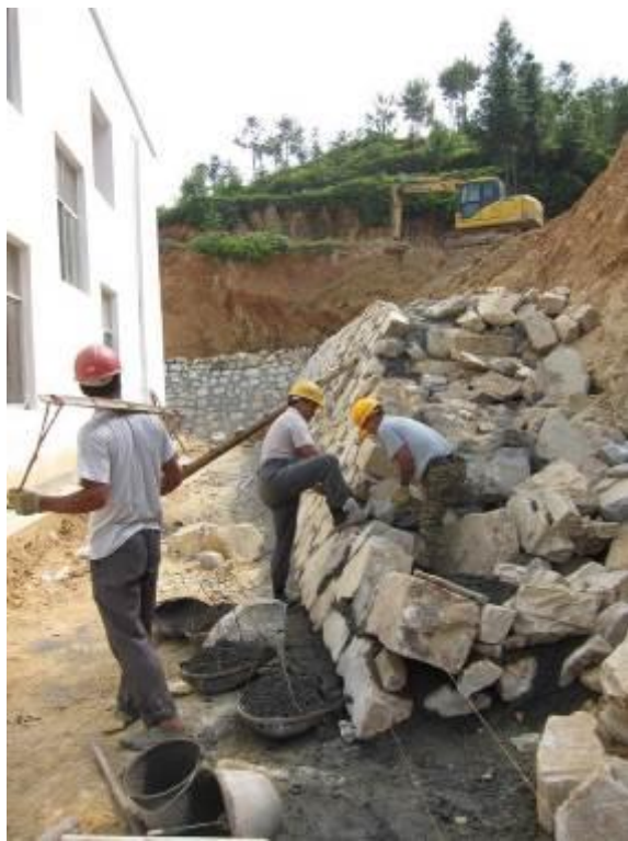
(6) 教学楼背面左侧, 护坡工程进行中
