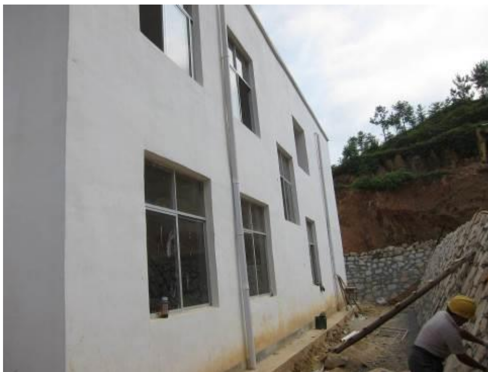
(5) 教学楼背面右侧, 护坡工程进行中
